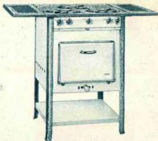
Cuisinières en tôle et fonte " Godin-Ega ", avec dessus à charnières pouvant être amené à la position verticale. Four avec porte à ressort. Toujours avec allonges pouvant être facilement rabattues, remises en place ou enlevées.
