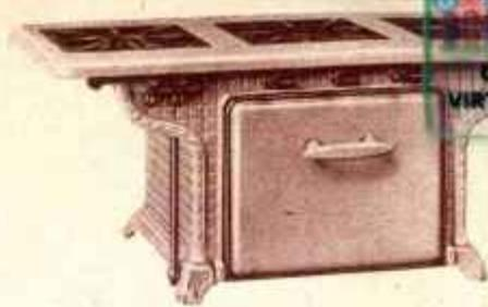
**Fourneau au gaz, 6 robinets, porte de four à ressort. Numéro 260<sup>A</sup>**
